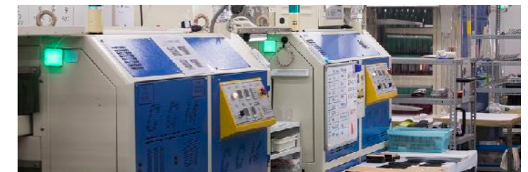
リアルタイムで環境測定 (異常時にはGravioライトで通知)
